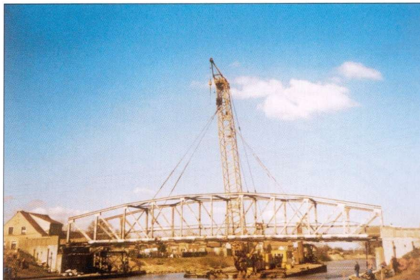
Zdjęcie 2: Przeniesienie części wierzchniej mostu za pomocą pływającego dźwigu „Ibis”
